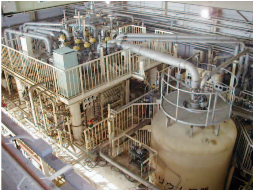
超伝導加速空洞用ヘリウム冷凍システム
